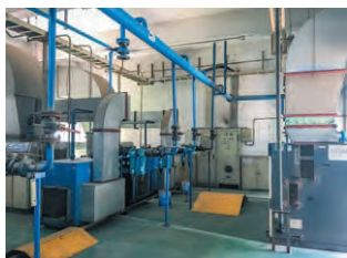
固定频率压缩机（295kW）5台
